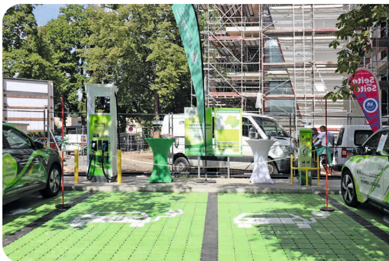
Hochleistungsladesäule (links) und Normalladesäule (rechts) am Neubau „Die tanzende Siedlung“, Kaßbergstraße 20 in Chemnitz
