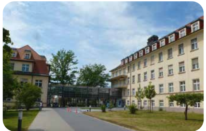
Die Häuser D und B sind mit einem Brückensystem verbunden
