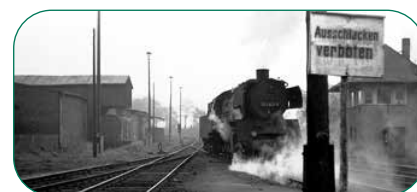
Ehemaliges Stellwerk visavis Verwaltungsgebäude (1977), Bild Thomas Böttger
