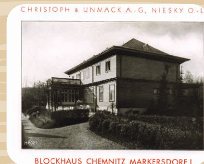
BLOCKHAUS CHEMNITZ MARKERSDORF I
